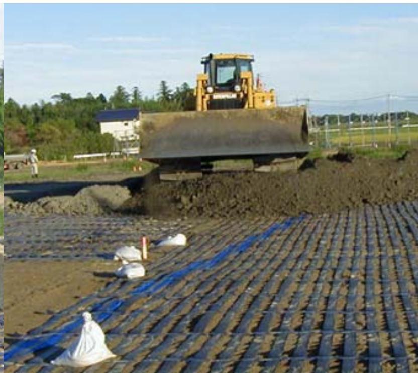
写真⑯ 敷均し、締固め
