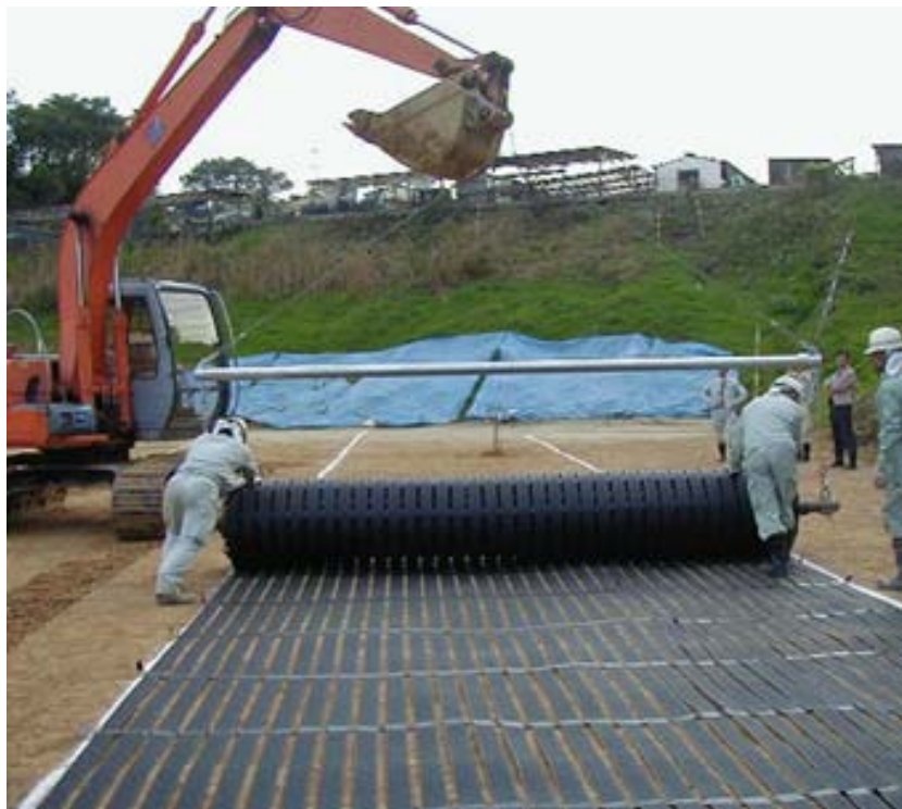
写真⑦ 敷設
