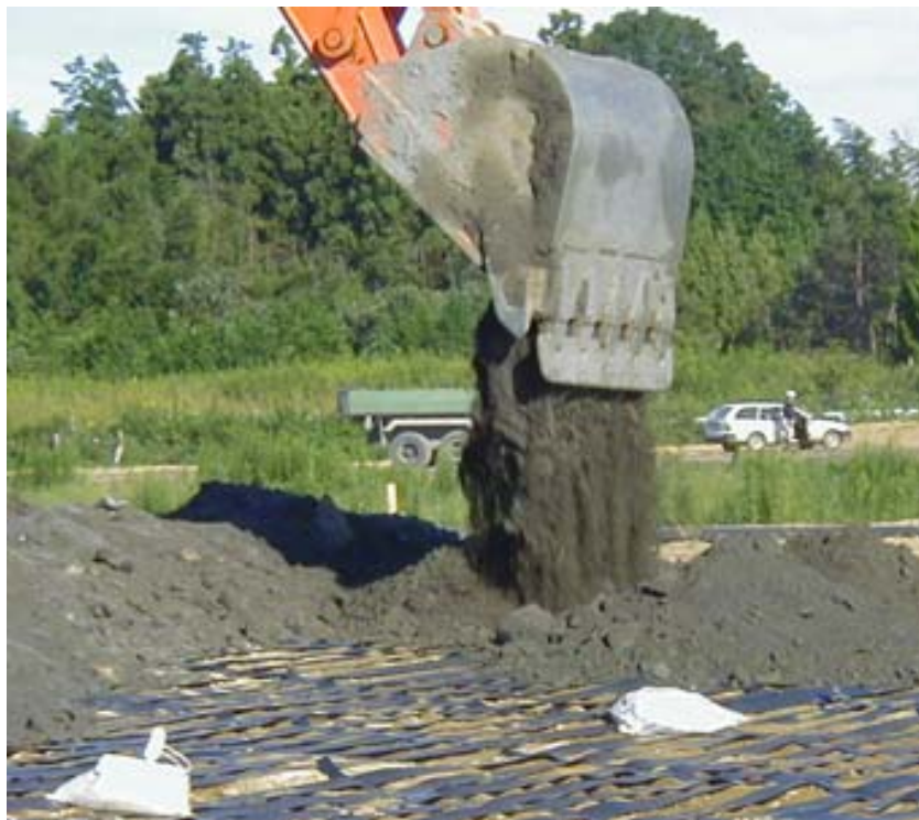
写真⑮ 土の撒き出し
