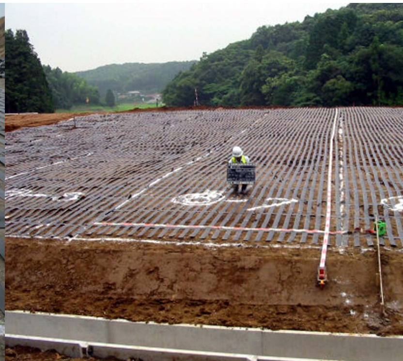
写真⑫ 敷設完了
