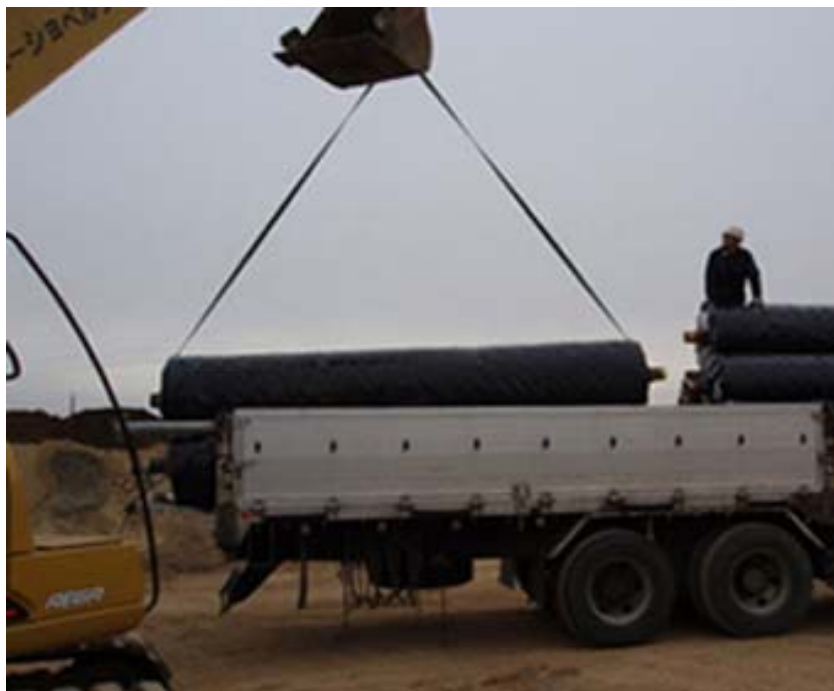
写真① 荷下ろし
